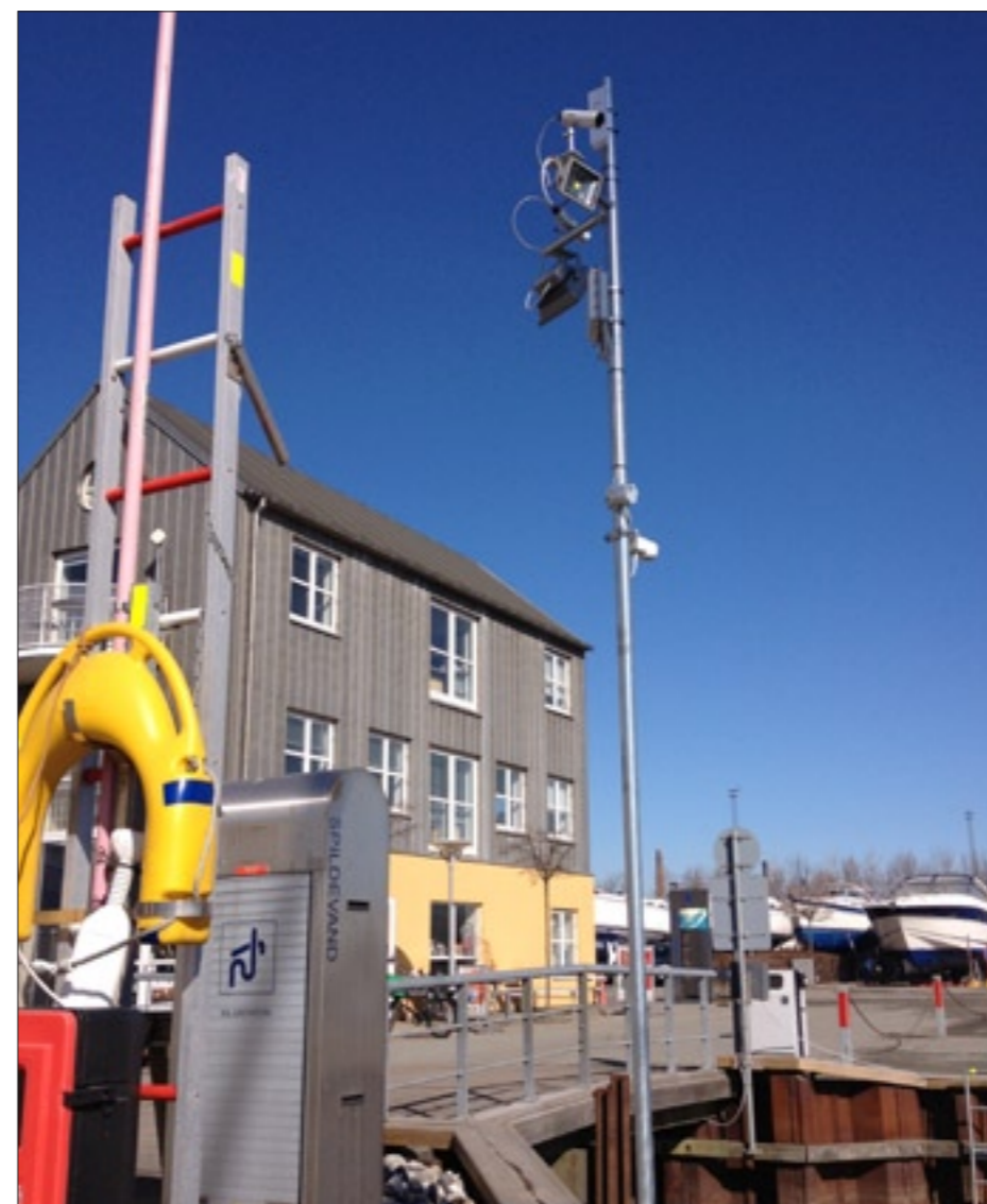
Arbejdslys og videoovervågning ved søsætnings- og servicekajen
