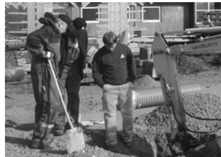
Jordarbejdet ved værkstedet er ved at være færdigt. Her er Jens Christian, Lars og en maskinfører ved at lokalisere kloakledningerne.
