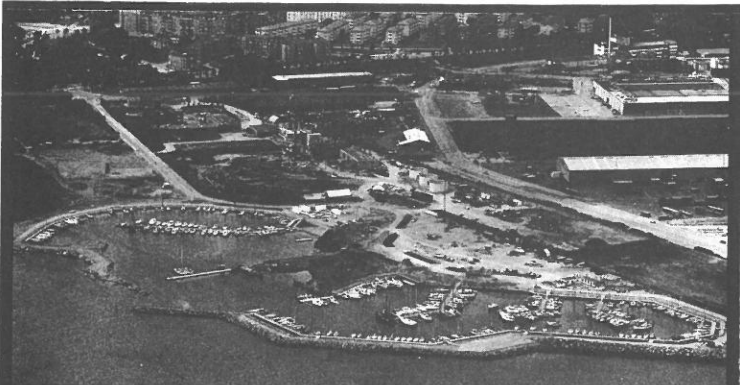
Havnebyggeriet , da det var på sit højeste. Marselisborg Havn har kostet 25 millioner kr. - og kommunen har ikke betalt en krone.
